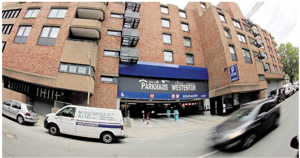
Hinter den Mauern des Parkhauses Westentor wurde über anderthalb Jahre lang gearbeitet. Entstanden ist eine Garage modernster Prägung.
